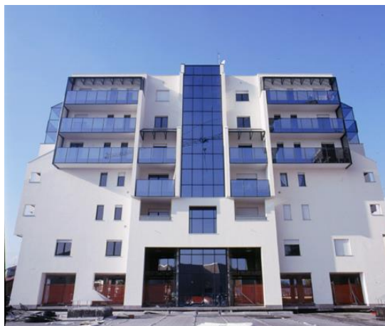
COMPLESSO RESID. "SANTA BARBARA" - BIELLA 2000
