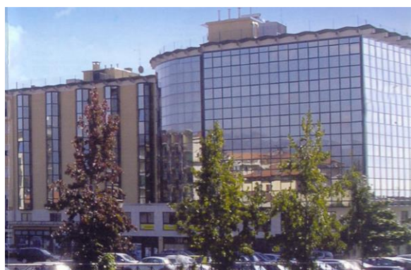
CENTRO COMMERCIALE "BIELLA OVEST" - BIELLA 2002
