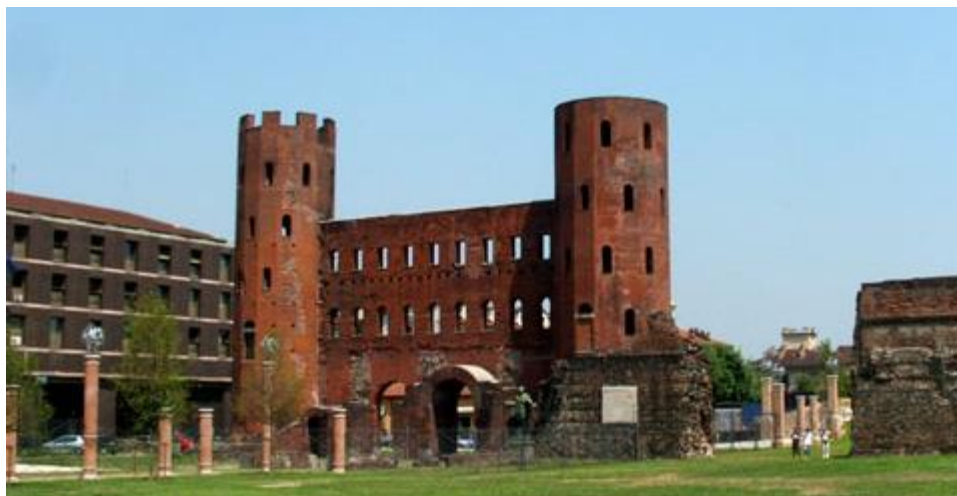
RISTRUTTURAZIONE PORTE PALATINE - TORINO
