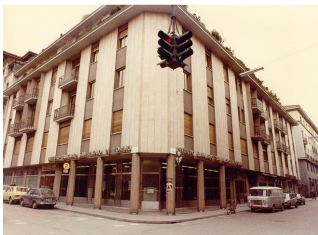
CONDOMINIO "GARIBALDI" - BIELLA 1969
