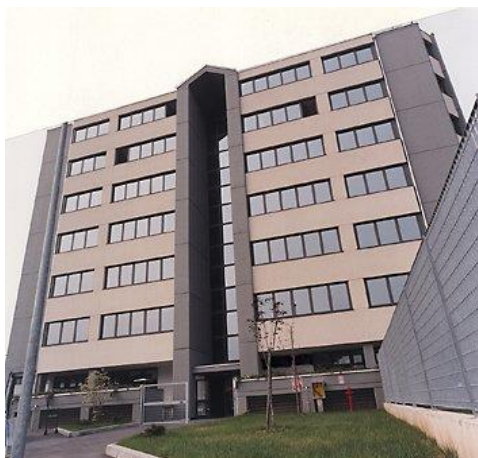
PALAZZO UFFICI - COLLEGNO 1999
